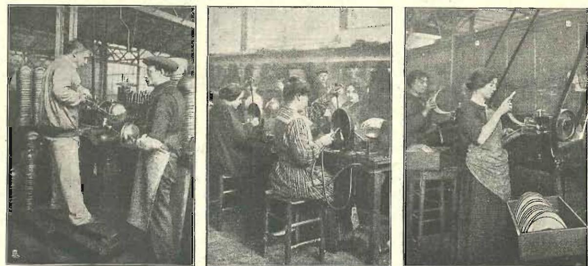
Fig. 6. Finimento dei bordi. — Fig. 7. Saldatura a gas delle visiere agli elmi. — Fig. 8. Preparazione delle visiere con residui risultanti dalla tagliatura dei dischi.
